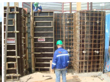
Ferrailage en cours
