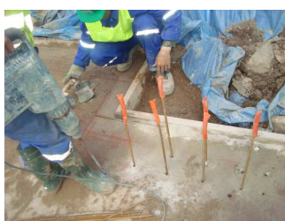
Ancrage des armatures à l'existant
