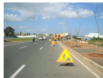
Signalisation du chantier
