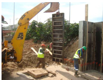
Coffrage en cours
