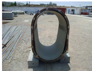
Montage à blanc tuyaux acier Et coques CCV
