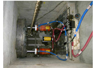
Fonçage en cours Derb El Kabaje dans la médina
