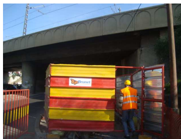
Installation du chantier sous pont ONCF
