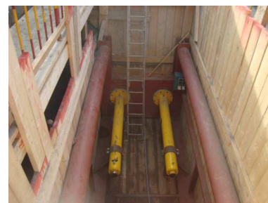
Mise en place de la station de poussée
