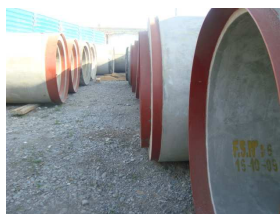
Les tuyaux de fonçage
