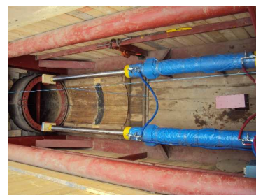
Mise en place de la tête de guidage du fonçage
