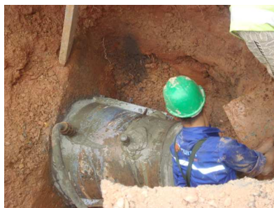
Injection de 'espace annulaire sous pression en cours
