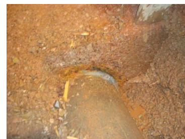
Colmatage de la fuite
