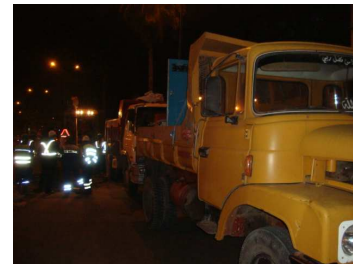
Terrassement en cours
