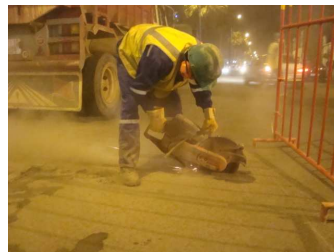
Installation de chantier Découpe de la chaussée
