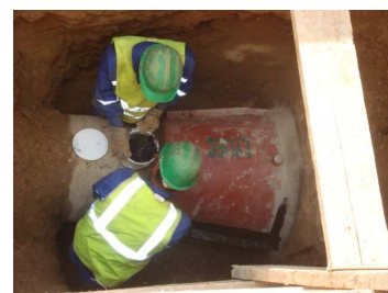
Mise en place de la protection sur le manchon
