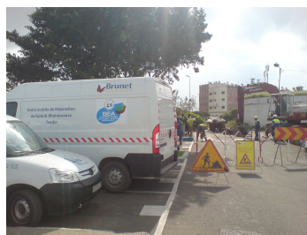
Installation de chantier Découpe de la chaussée
