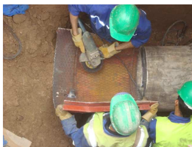
Pose du manchon en cours Avec joint hydro gonflant
