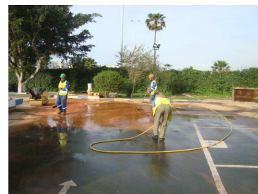
Remblaiement et nettoyage
