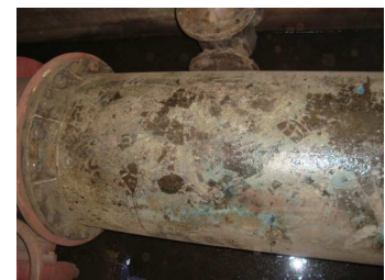
Décapage de la conduite existante
