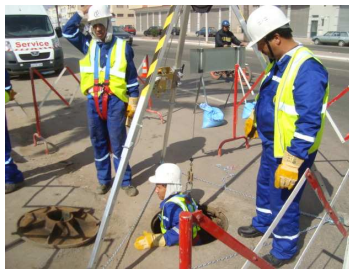
Installation de chantier Descente dans l'ouvrage
