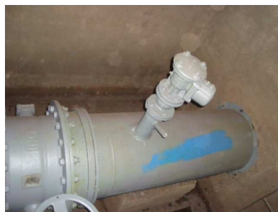
Couche de protection et peinture Sur les conduites et la robinetterie
