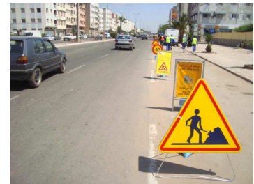
Signalisation du chantier
