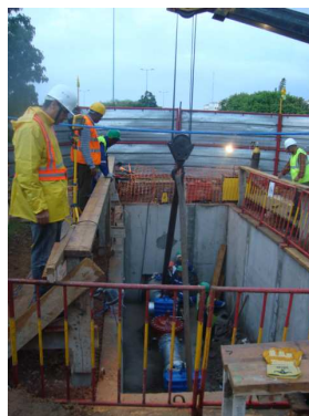
Pose de la Robinetterie
