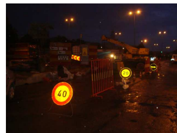
Signalisation du chantier
