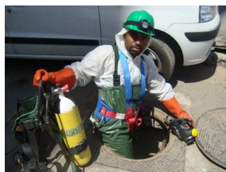
Équipement de sécurité D'un égoutier
