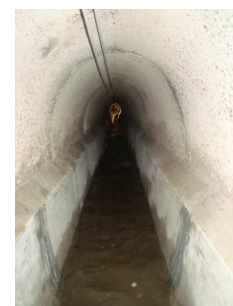
Après réhabilitation : radier continu
