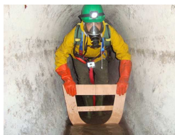
Passage du gabarit avant fabrication des coques
