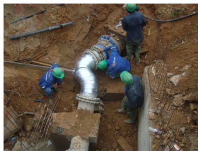
Raccordement terminé La conduite est en exploitation
