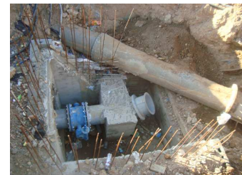
Vue générale du chantier
