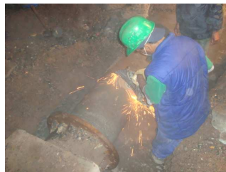
Découpe de la conduite existante
