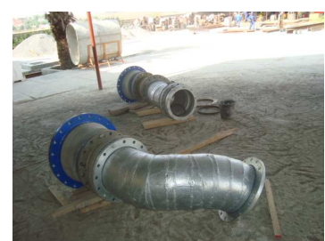
Pré-montage des pièces spéciales
